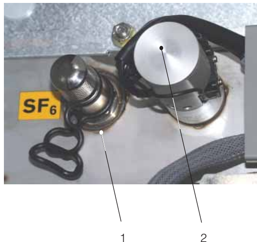
Рис. 7.12.1. Газонаполнительный разъем (1) и датчик плотности (2)
