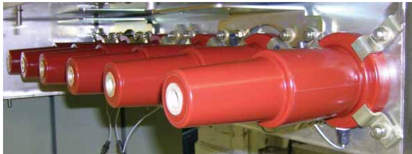
Рисунок 7.6.1: Отсек кабельных подключений с наружными коническими выводами в воздухе, без кабельных адаптеров (во время сборки на заводе, без отсека кабельных подключений)
