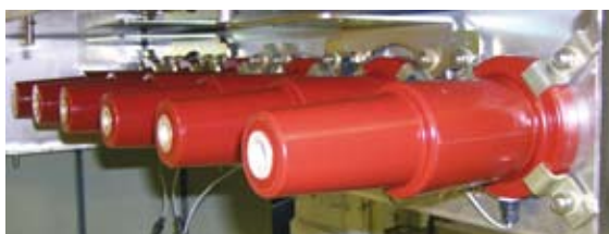
Рис 6.6.2. Внутренняя конструкция отсека кабельных подключений с наружными коническими вводами в воздушной атмосфере без кабельных штекеров (в процессе заводского монтажа без отсека кабельных подключений)
