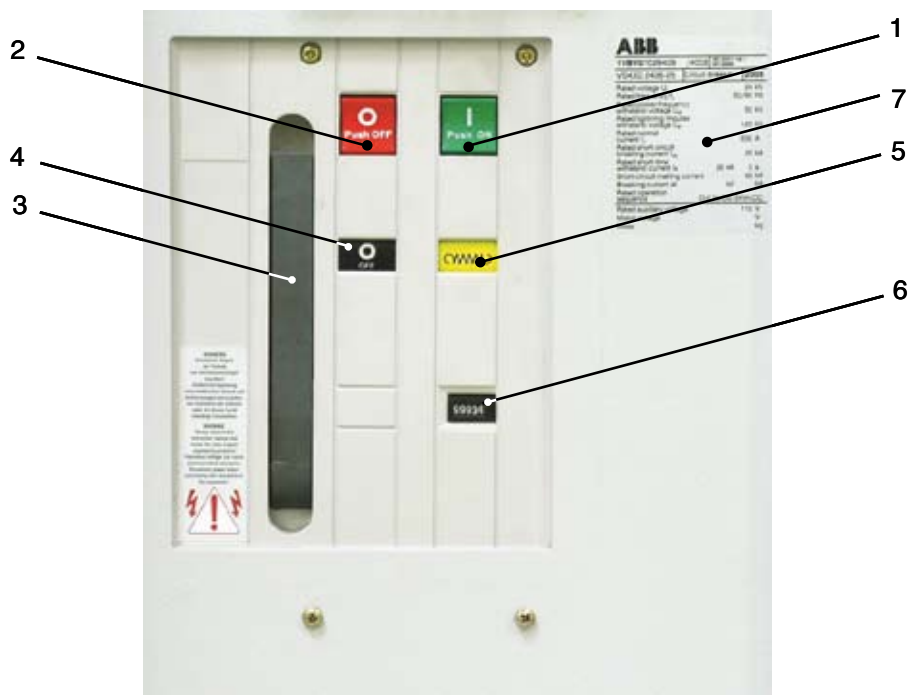
Рис. 6.1.4. Сторона обслуживания привода силового выключателя
