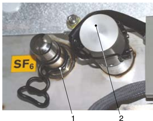
Рис. 6.13.1. Газонаполнительный патрубок (1) и датчик концентрации (2)
