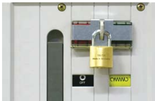
Рис. 6.1.6. Блокировка навесным замком
