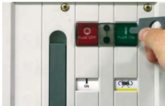
Рис. 6.1.5. Блокировка от бесконтрольного нажатия
