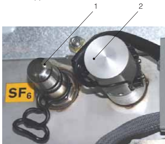
Рис. 7.12.1. Газонаполнительный разъем (1) и датчик плотности (2)
