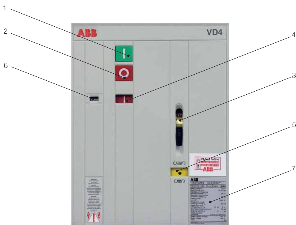
Рисунок 7.1.4: Элементы управления выключателем
