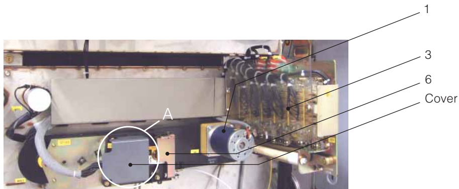
Рис. 7.2.4. Привод трехпозиционного разъединителя с блок-контактами (3) и механической блокировкой для аварийного ручного управления (6)
