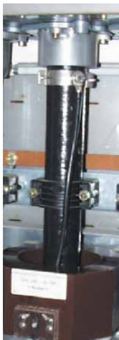
Рис. 7.4.2.1. Подключение полностью изолированной шины с применением штекерного разъема типоразмера 3
