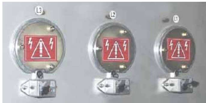
Рис. 7.7.1. Однофазная система LRM (ниже испытательных разъемов)
