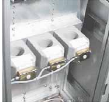
Рис. 7.8.3.1. Датчики с кольцевыми сердечниками
