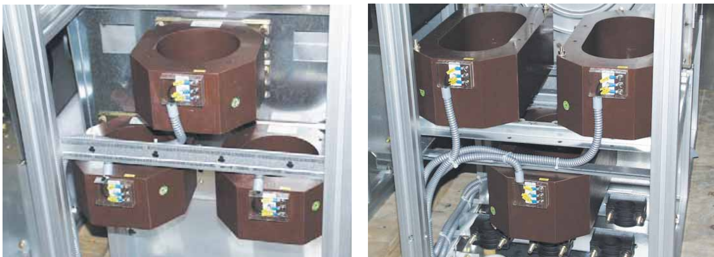
Рис. 7.8.2.1. Трансформатор тока с кольцевым сердечником
